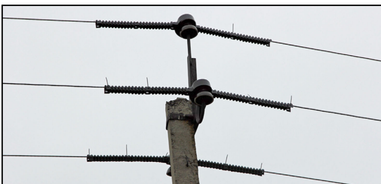
Оқишаулағыш құстарды қорғау құрылғылары бар 10 кВ электр беру желісінің басы. Р. Бекмансуровтың фотосы.
