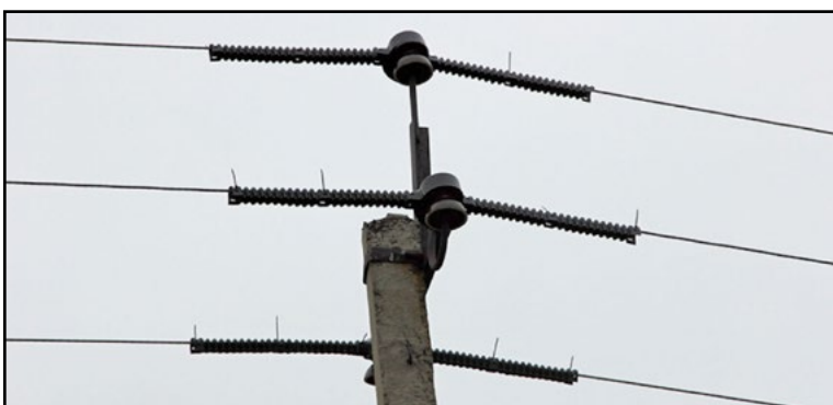
Оқишаулағыш құстарды қорғау құрылғылары бар 10 кВ электр беру желісінің басы. Р. Бекмансуровтың фотосы.
